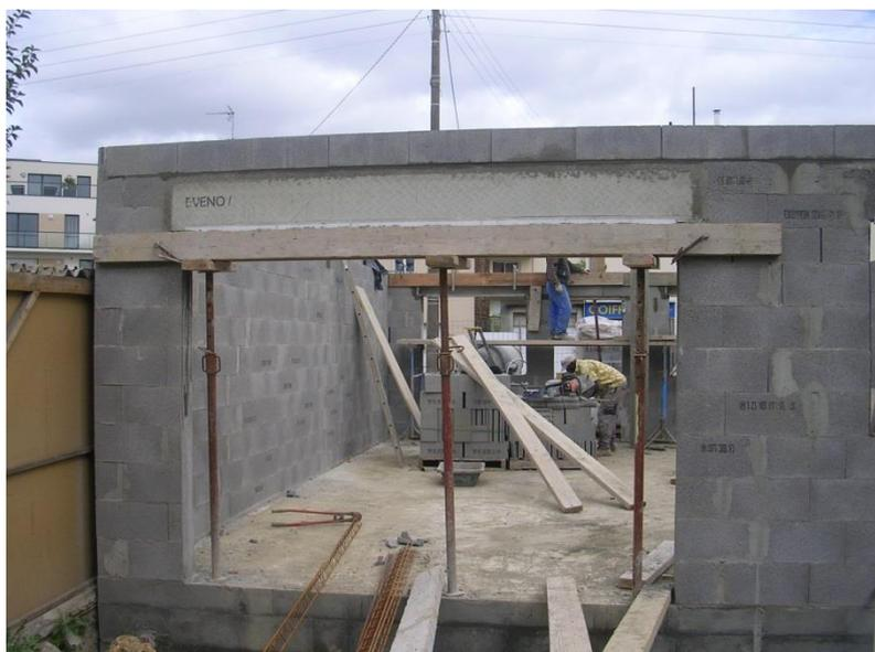
Afin d'assurer l'homogénéité de la paroi, le Système Constructif **EASYTHERM**<sup>®</sup> étoffe son offre en développant avec la société **EVENO**, une gamme de coffre tunnel composite, avec une face extérieure **EASYTHERM**<sup>®</sup> et une face intérieure composée d'une coque en mousse PU isolante et structurale assurant une haute performance thermique et une étanchéité à l'air pérenne.
