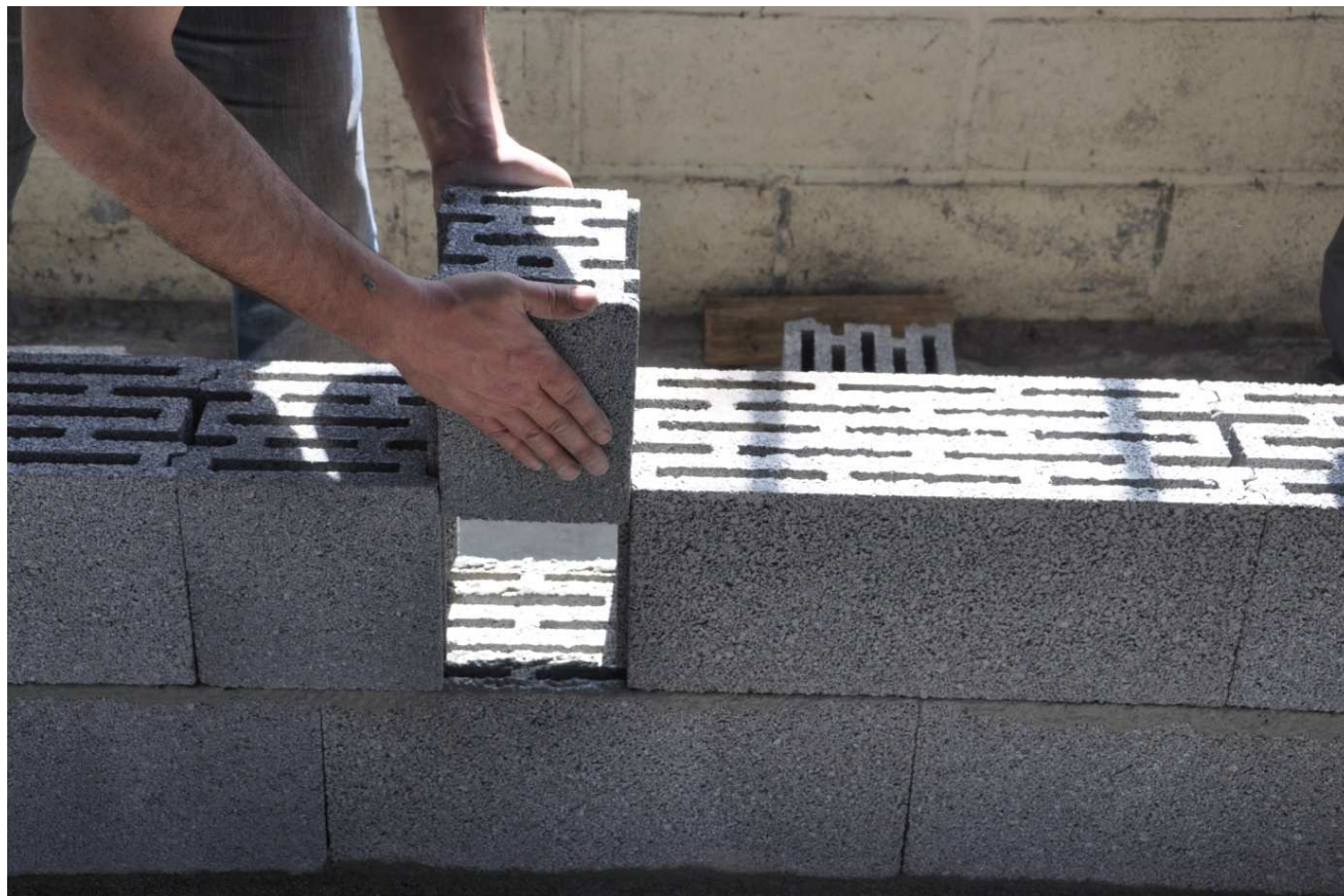
Mise en place d'un module EasyTherm
